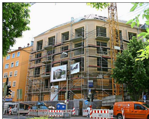
Noch steht das Gerüst, doch innerhalb der nächsten Tage soll es verschwinden und den Blick darauf frei machen, wie das Bismarckhaus aussehen soll. Foto: Benjamin Schieler
