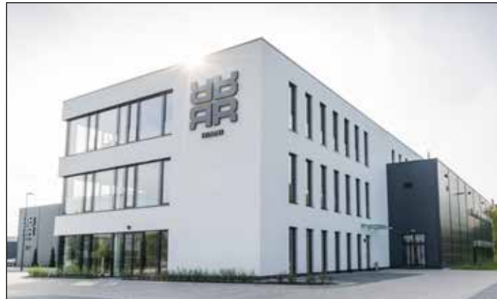
Vorbildlich für einen Industriebau: Der Riani-Sitz in Schorndorf
