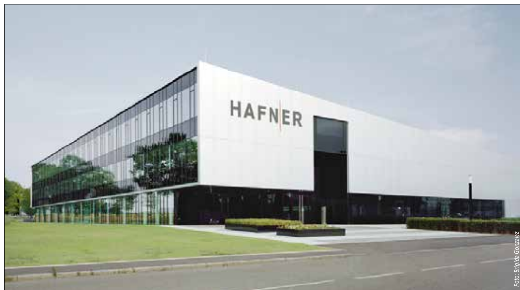
Die Metallfassade weist darauf hin, welcher Werkstoff innen überwiegend verarbeitet wird
